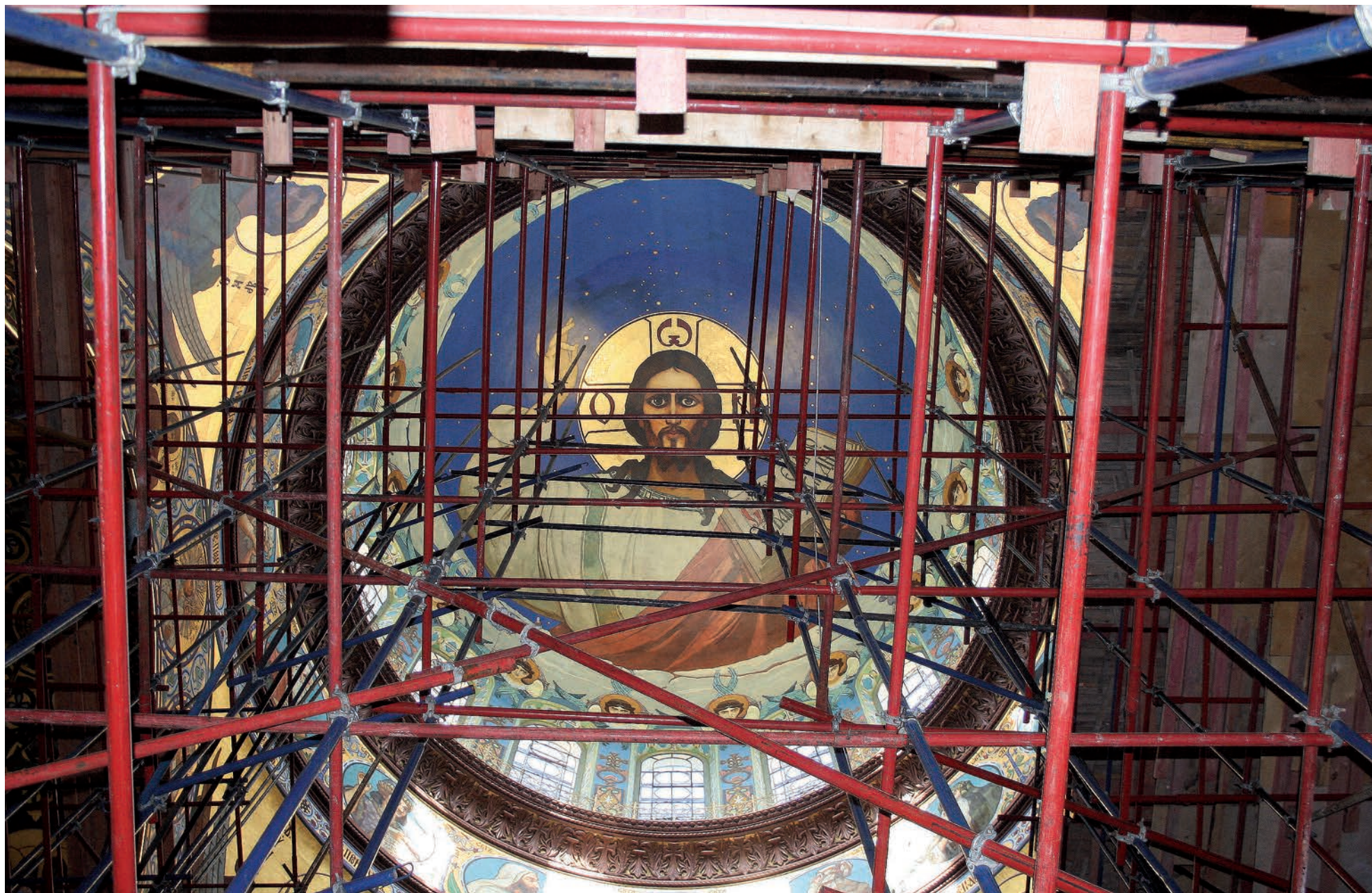
Внутри Вознесенского собора идёт ремонт
